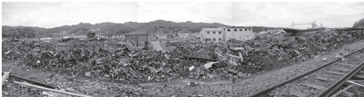
釜石線（不通）線路上から見た気仙沼海岸市街地の惨状（2011.4.20.撮影） ＝上部（対岸）丘陵の手前が気仙沼湾。右の写真の大型漁船は陸に取り残されている
