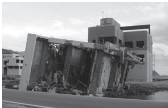
液状化による中層ビルの倒壊(大船渡市内 2011.11.22.撮影)
