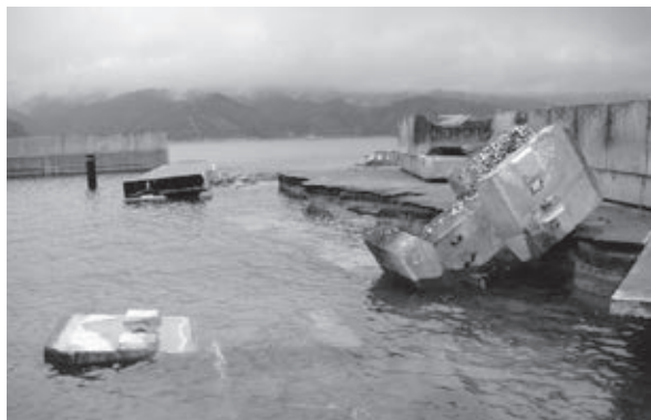
海岸堤防の決壊状況(宮古市内 2011.6.13.撮影)
