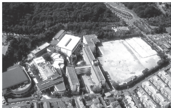
平和が丘キャンパス全景（平成5年頃）
